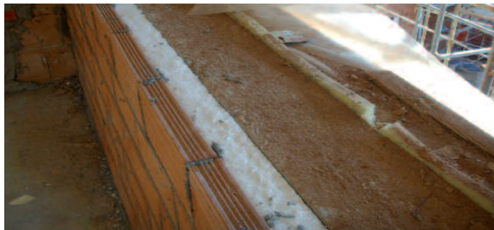
Posizionamento dell'isolante nella parete perimetrale.
