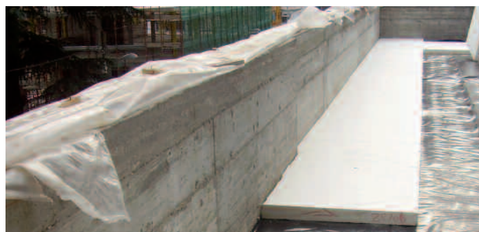
Posizionamento dell'isolante sulla soletta.
